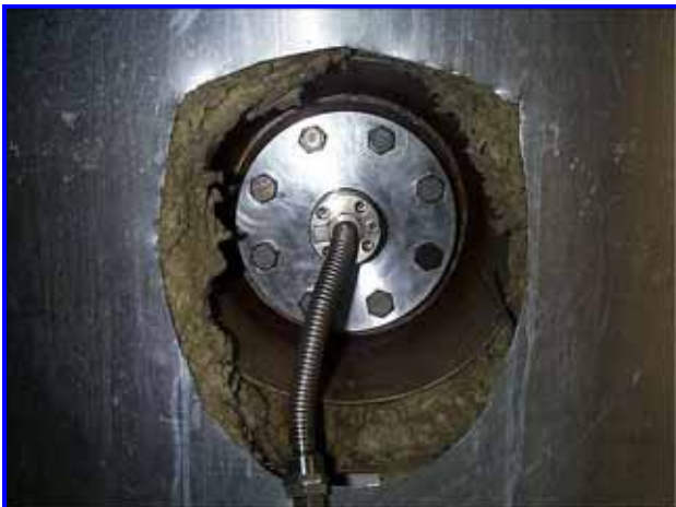
Montage sur cuve
