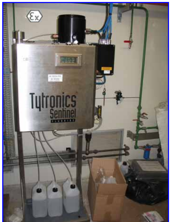
Suivi de perçage de conduite en zone ATEX
