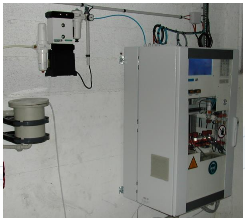
Rejets d'usine d'incinération d'ordures ménagères
